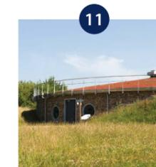
Energiewende konkret: Der eindrucksvolle 4.000 Kubikmeter Wasser fassende Multifunktionspeicher ist an das Fernwärmenetz angeschlossen.
